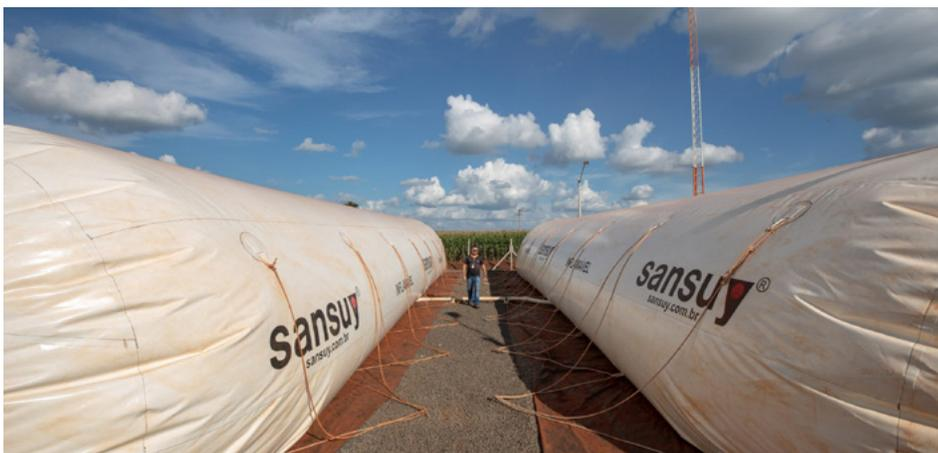
Figura 33 - Detalhes dos sistemas de armazenamento do gás, na unidade de geração de eletricidade com biogás, em Entre Rios do Oeste
